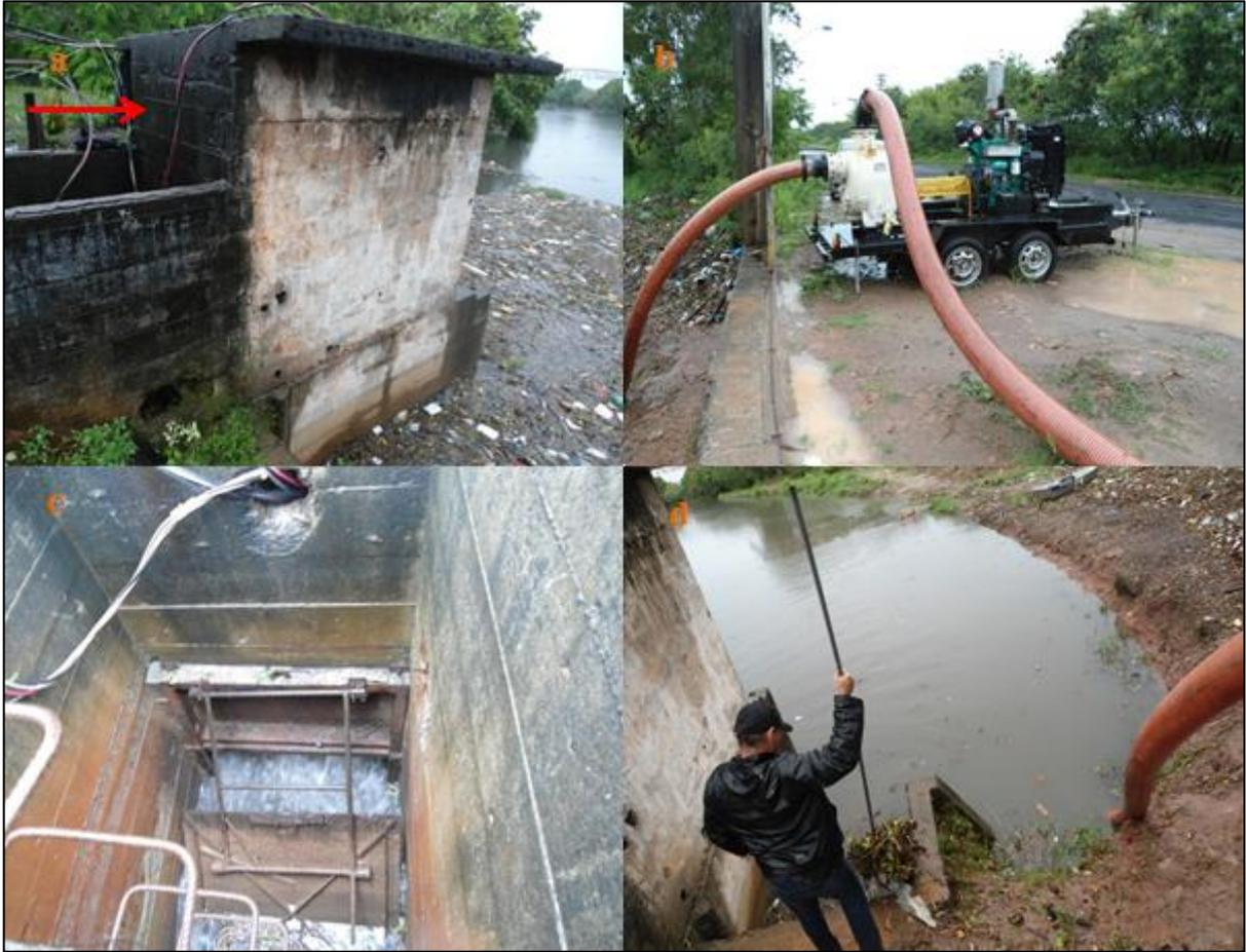
Figura 86 - a) Estrutura de concreto onde se localizam as duas bombas fixas na saída do Canal de Araçás. b) Bomba extra para ajudar em eventos extremos. c) Comporta Manual na saída do Canal de Araçás. d) Funcionário da prefeitura retirando lixo na entrada da comporta. Fotos: Miquelina Deina em 19-03-2013.
