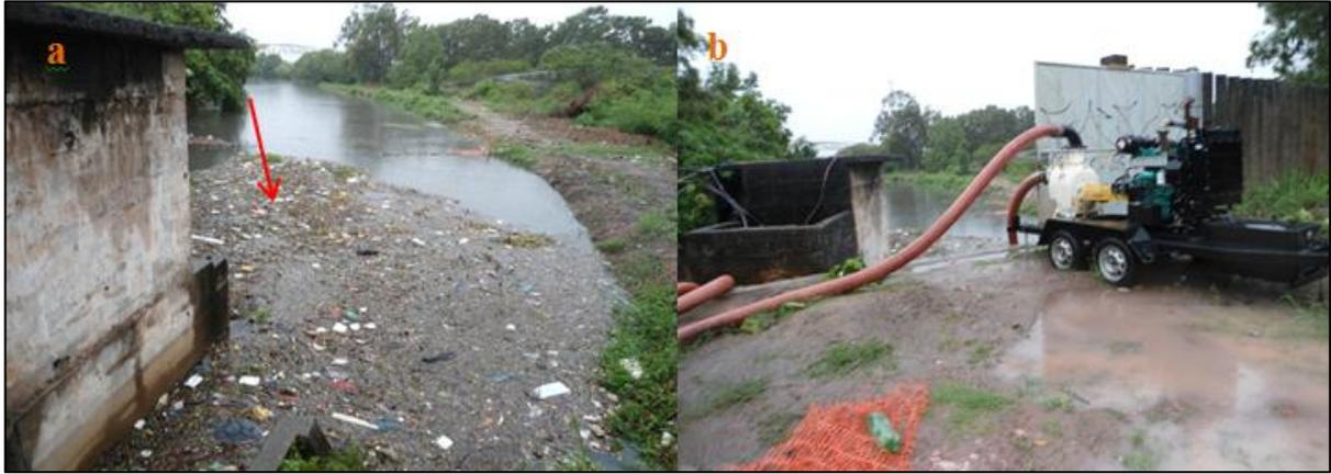
Figura 82 - a) Saída do Canal de Araçás na altura das comportas. b) Bomba extra para ajudar no bombeamento d'água para fora do canal. Fotos: Miquelina Deina em 19-03-2013.
